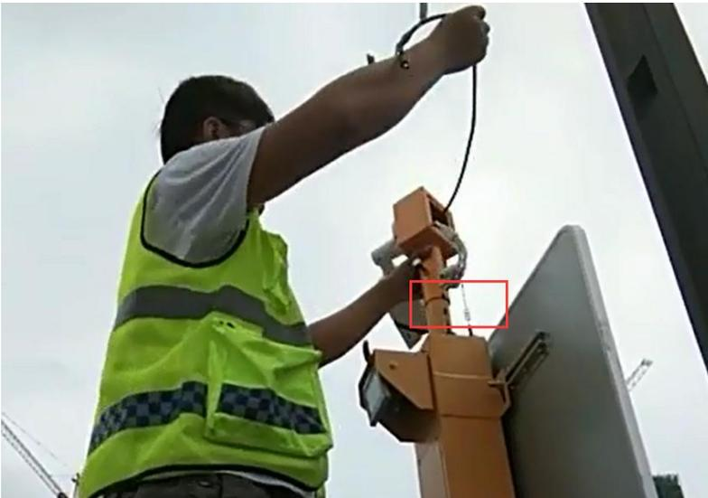
3.5 将智能多功能柱与相机的电源线以及信号线相连接，如下图所示
